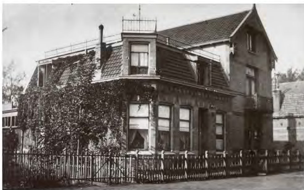
Het woonhuis van Jan Stuurman Dz. en zijn gezin, aan de Lagendijk 27 te Koog. Vandaag de dag is dit de plek waar men het fabrieksterrein van Tate & Lyle oprijdt (foto GAZ).
